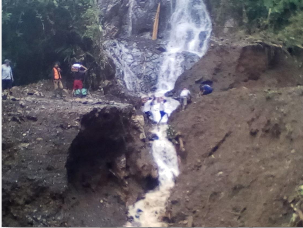
Derrumbe para acceso a Kosñipata (15 de febrero de 2020)
