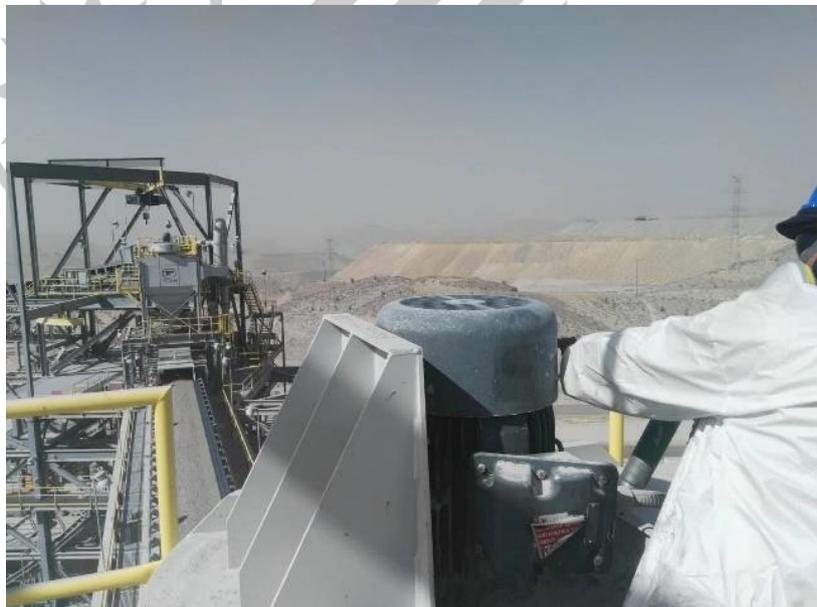
una manguera con la suficiente distancia para que el punto de ingreso de grasa este fuera de alcance de los equipos en movimiento y el personal no corra riesgo alguno, se identifican los puntos de engrase del motor del colector de polvo, se procede a limpiar con trapo industrial el punto de engrase que va al sello del eje en motor, posteriormente
