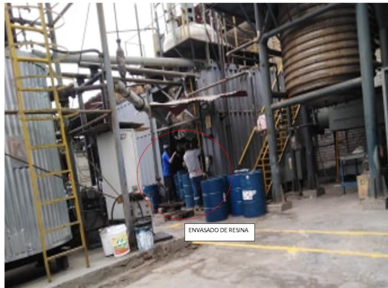
Figura 22 Zona de Envasado de Resina
