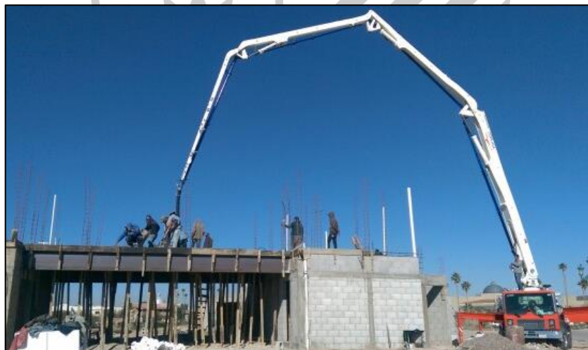
Bombeadora de concreto
