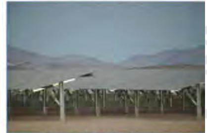
Instalación de Módulos Fotovoltaicos
