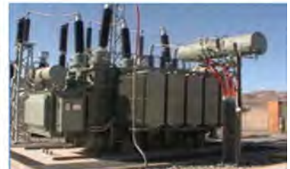
Transformador de Potencia 20 MVA, 23/138 kV
