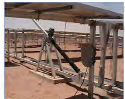
Instalación de Seguidor Solar
