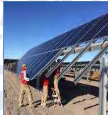
Montaje de paneles
