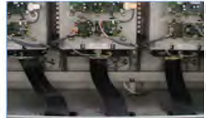
Circuito de Salida (A.C.) de Inversores (3Ø)
