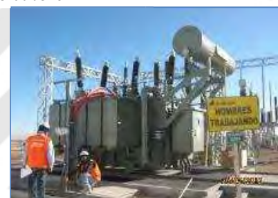
Transformador de Potencia 20 MVA, 23/138 kV (S.E. Central Majes Solar (S.E. Pedregal))
